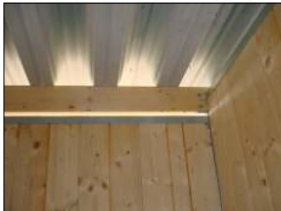
Takplåt monterad, sett inifrån.
