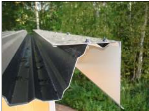
Vindskiva monterad
